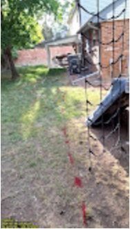
DigTix Ticket B419001971 2024-07-09 19:03:07.445.jpg 317K
