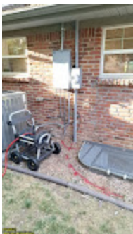
DigTix Ticket B419001971 2024-07-09 19:03:17.412.jpg 233K
