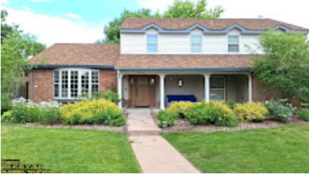
DigTix Ticket B419001971 2024-07-09 17:39:51.097.jpg 259K
