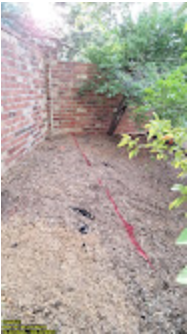
DigTix Ticket B419001971 2024-07-09 19:02:03.361.jpg 316K
