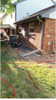
DigTix Ticket B419001971 2024-07-09 19:03:12.380.jpg 295K
