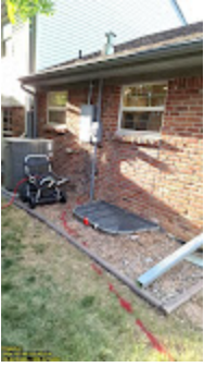
DigTix Ticket B419001971 2024-07-09 19:03:14.390.jpg 246K
