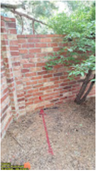
DigTix Ticket B419001971 2024-07-09 19:02:08.296.jpg 285K
