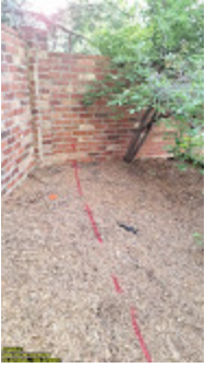
DigTix Ticket B419001971 2024-07-09 19:02:05.963.jpg 310K
